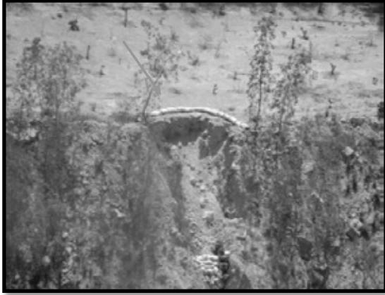
Ilustración 86. Barrera de costales para evitar erosión en cárcava.
