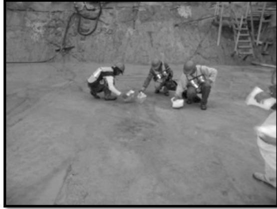
Ilustración 65. Uso de material absorbente (esponja) para atención a derrames accidentales de hidrocarburos
