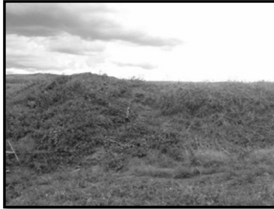
Ilustración 98. Material acopiado en zona de oficinas con presencia de herbáceas debido al temporal de lluvias
