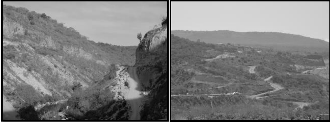
Ilustración 37. Desarrollo de vegetación a los costados de los caminos internos del proyecto.
