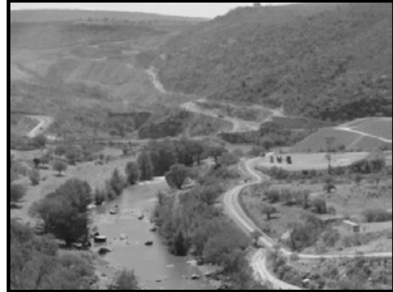
Ilustración 43. Vista panorámica de las vialidades nótese la presencia de vegetación.
