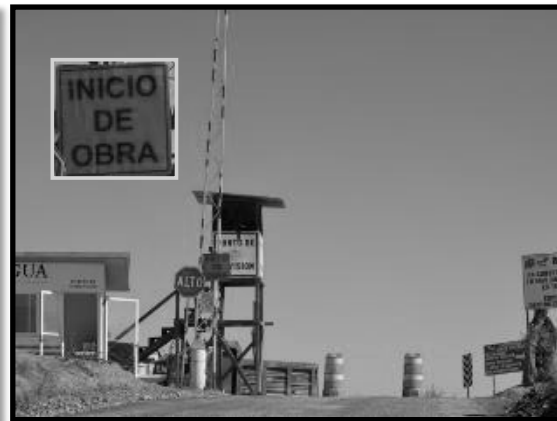
Ilustración 98. Puerta de acceso principal al proyecto, en la cual ha sido colocado cartel alusivo al inicio de obra.
