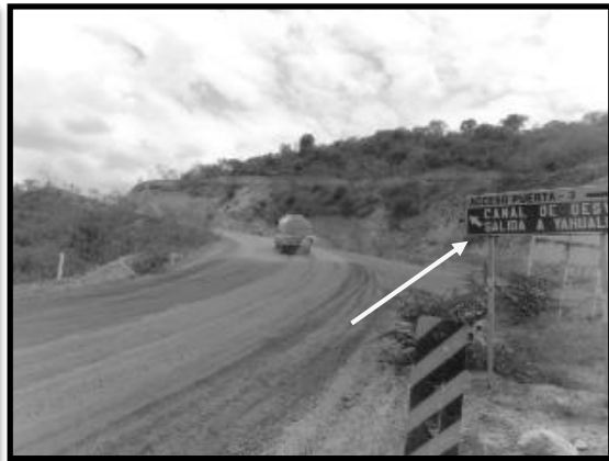
Ilustración 121. Señalamientos en caminos para identificación de áreas en obra.
