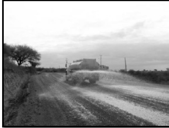
Ilustración 22. Riego de caminos internos del proyecto con agua residual tratada.
