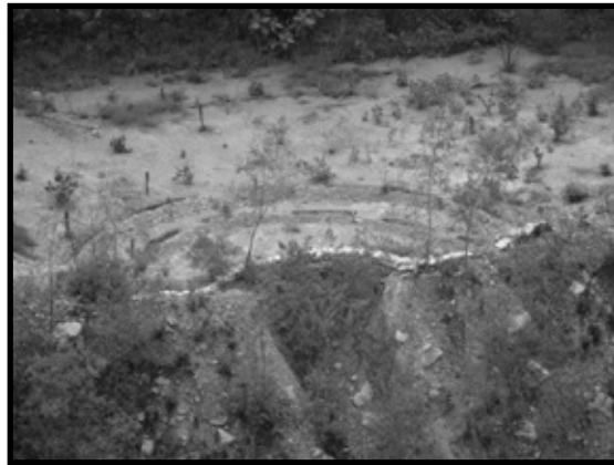
Ilustración 63. Vista panorámica de obras de conservación de suelos
