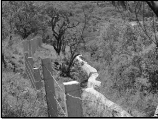
Ilustración 109. Obras para manejo de escurrimientos pluviales en obra.
