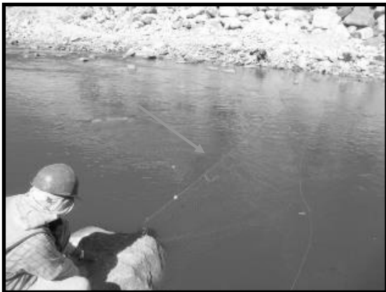
Ilustración 182. Colocación de tumbo para actividades en cauce previo al ingreso de la maquinaria.
