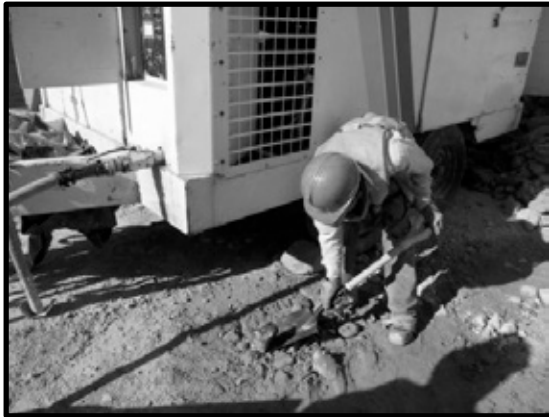
Ilustración 131. Retiro de suelo contaminado por hidrocarburo.
