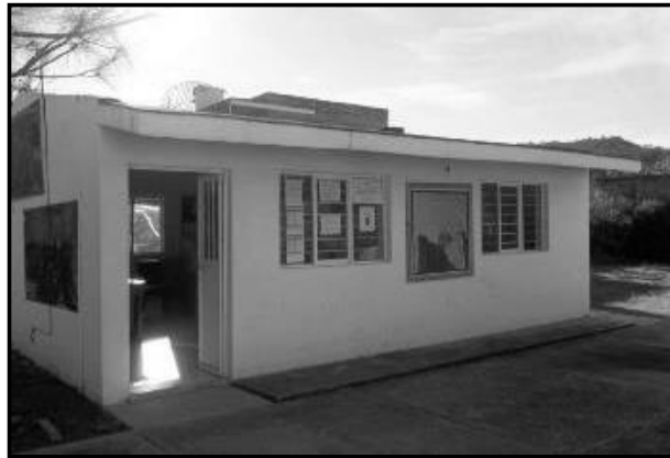
Ilustración 4. Casa de atención permanente en el poblado de Acasico.
