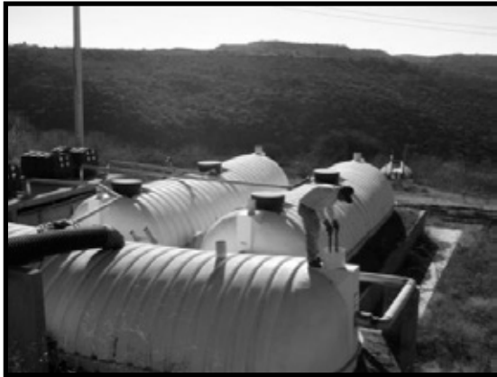
Ilustración 19. Vista de Planta de Tratamiento de Aguas Residuales (PTAR).
