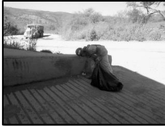
Ilustración 144. Limpieza de las diferentes áreas de obra para evitar su dispersión hacia otros predios.
