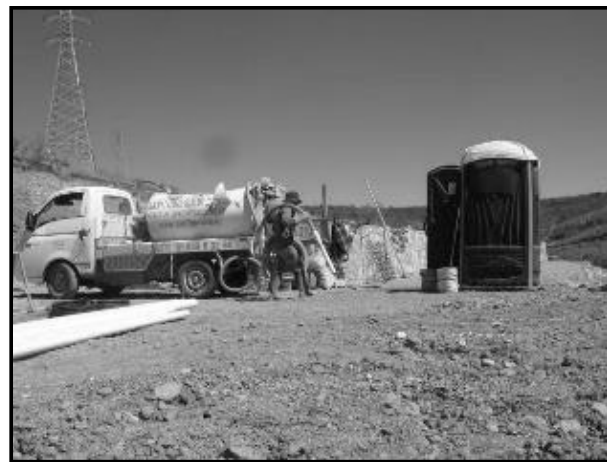
Ilustración 119. Personal de la empresa SANITUBO, haciendo limpieza de rutina en la subestación eléctrica.
