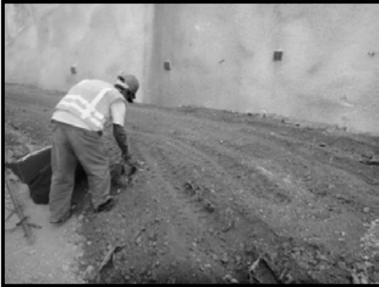
Ilustración 12. Recolección de residuos en área de construcción de cortina.
