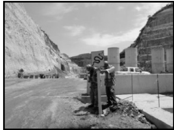
Ilustración 77. Señalamiento vial de presencia de serpientes en el área.
