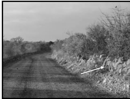
Ilustración 36, Cerco de piedra que se observa en el acceso a la zona de obra de la Presa El Zapotillo.
