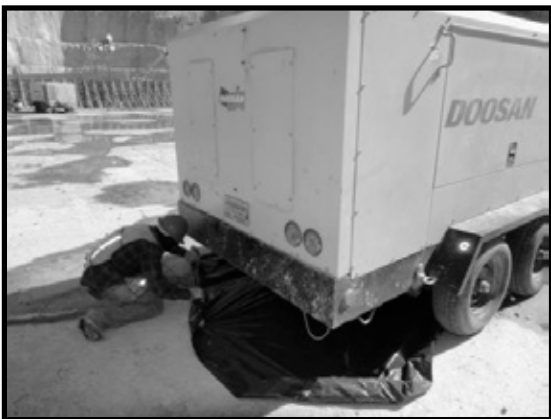
Ilustración 88. Colocación de bases plásticas para evitar derrames al suelo.
