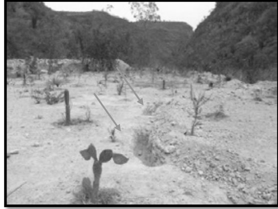
Ilustración 87. Construcción de tinas ciegas en área Zula.
