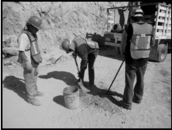
Ilustración 81. Retiro de suelo contaminado por derrame accidental de hidrocarburos, en camino interno del Proyecto de cortina.
