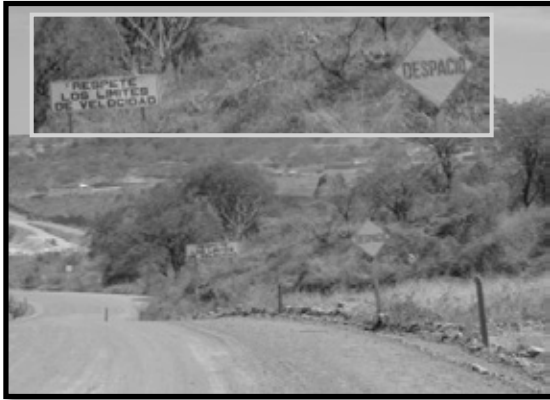
Ilustración 140. Señalamientos viales preventivos en camino principal.
