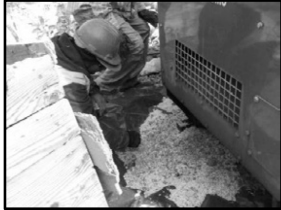
Ilustración 125. Aserrín como material absorbente en caso de derrames accidentales.
