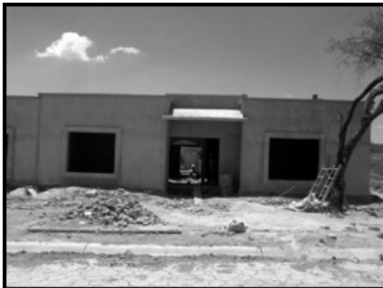
Ilustración 31. Aplanados en muros y bóveda en manzana 4, lotes 2, 4, 5,6 y 7.
