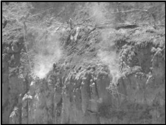
Ilustración 84. Proceso de anclaje en la parte superior del área de toppling.
