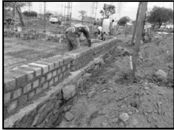
Ilustración 30. Trabajos preliminares y de cimentación sobre la manzana 4.
