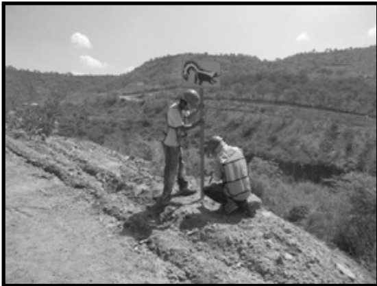
Ilustración 90. Instalación de señalamiento de presencia de fauna posterior a su mantenimiento.
