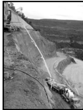
Ilustración 69. Colado de pilas en la margen izquierda superior
