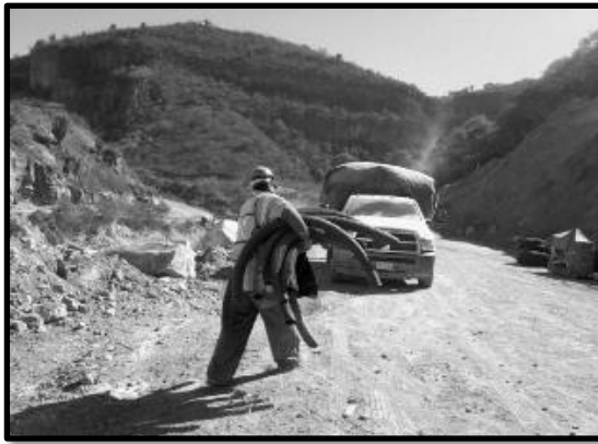
Ilustración 143 Retiro de residuos generados en los frentes de trabajo.
