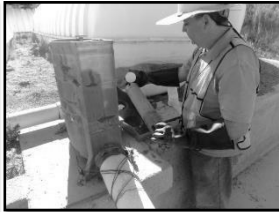
Ilustración 24. Colocación de pastillas tricloro en dosificador.
