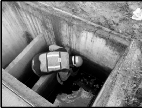
Ilustración 127. Limpieza de trampa de grasas del taller de maquinaria
