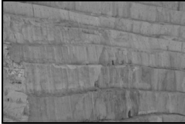
Ilustración 82. Cobertura de concreto de bermas en margen derecha.
