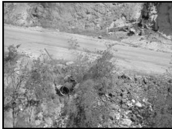
Ilustración 128. Obra de drenaje para conducción de agua pluvial en camino interno.
