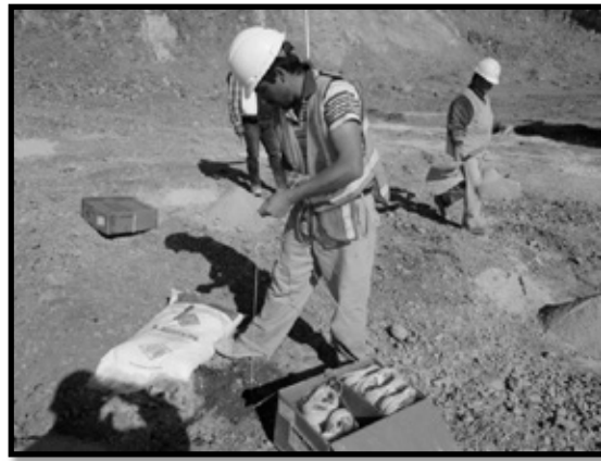
Ilustración 20. Colocación de explosivos para de voladura en Banco Potrero, Convenio y El Victoriano "La Palma"
