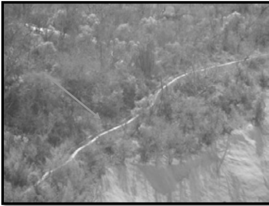
Ilustración 113. Obras para manejo de escurrimientos pluviales en obra.
