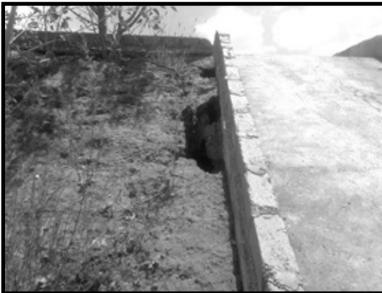
Ilustración 39. Socavón generado en lavadero pluvial del talud oeste.
