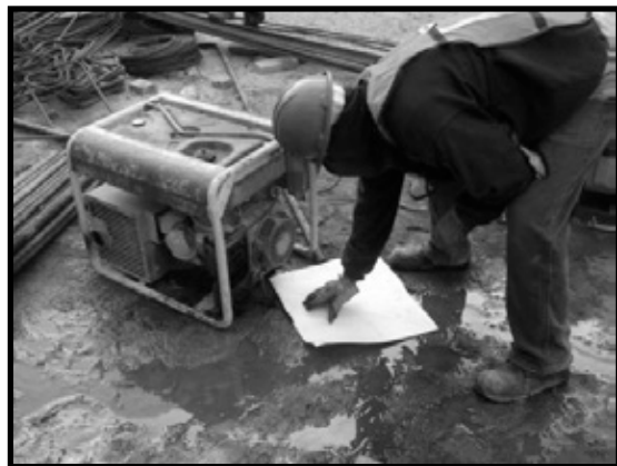
Ilustración 89. Atención a derrames en capa edáfica empleando telas absorbentes de hidrocarburos.
