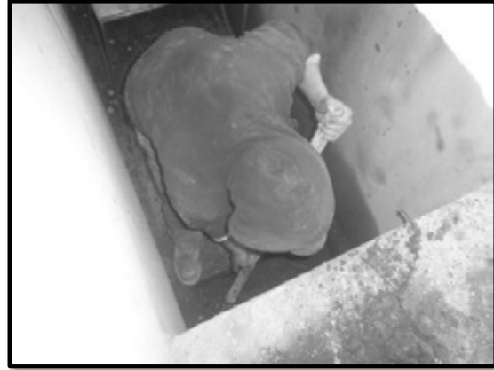
Ilustración 134. Limpieza de trampa de grasas ubicada en taller de mantenimiento.
