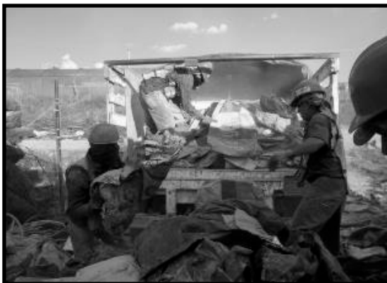
Ilustración 17. Depósito de residuos para su almacenaje temporal.
