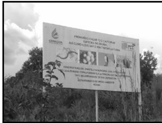
Ilustración 74. Cartel concerniente a la protección de la flora y fauna instalado en obra
