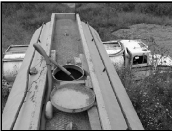
Ilustración 14. Llenado de pipa con agua tratada
