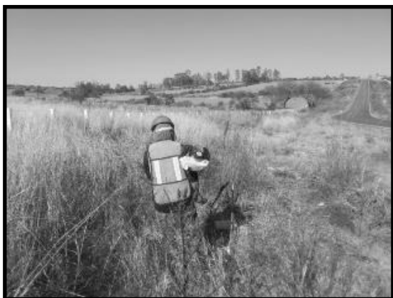
Ilustración 44. Mantenimiento y deshierbe de zona reforestada en Libramiento Yahualica.
