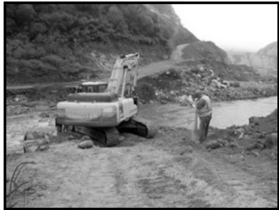
Ilustración 143. Personal de la brigada ambiental con atarraya para el rescate de peces durante las actividades de construcción.
