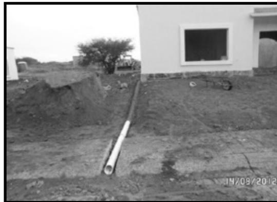
Ilustración 32. Construcción de drenaje de salida pluvial en lotes de la manzana 4.
