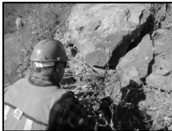
Ilustración 114. Verificación de inactividad de madrigueras observadas previo a las labores de desmonte.
