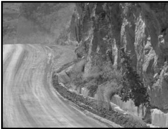
Ilustración 127. Cuneta de conducción de aguas pluviales en Camino VCD-8.
