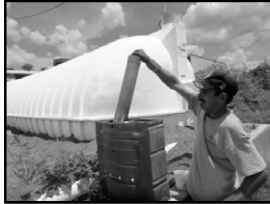
Ilustración 17. Revisión de pastillas de cloro en PTAR.
