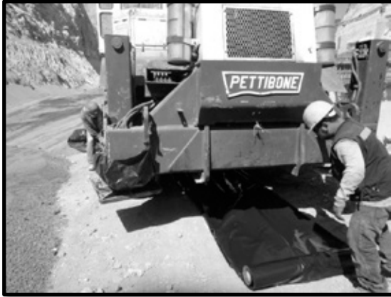
Ilustración 122. Colocación de bases plásticas para evitar derrames de hidrocarburos.
