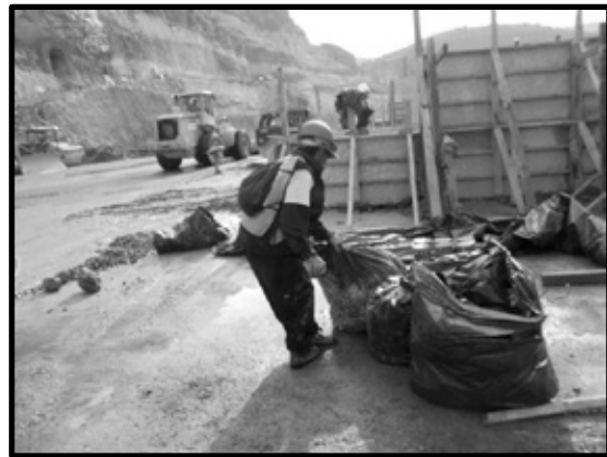
Ilustración 125. Retiro de bolsas con residuos sólidos urbanos de los frentes de trabajo
