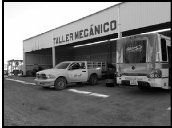
Ilustración 128. Taller mecánico para mantenimiento/correctivo de maquinaria y equipos.
