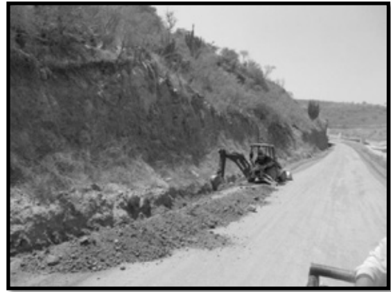
Ilustración 114. Desazolve de cunetas en vialidades internas del proyecto para el correcto escurrimiento de aguas pluviales.
