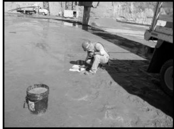
Ilustración 82. Uso de toallas absorbentes para la atención a derrames en la cortina.
