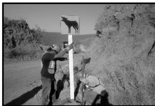
Ilustración 112. Instalación de nuevo señalamiento de Coyote ( Canis latrans ).
