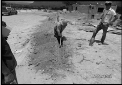
Ilustración 35. Demoliciones y desmantelamientos para alojar instalación eléctrica.
