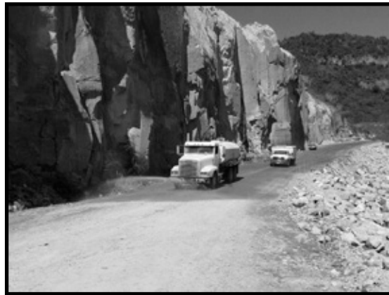
Ilustración 19. Riego de camino de acceso al área de cortina
