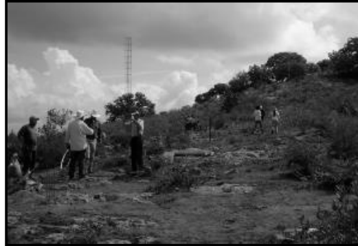
Ilustración 176. Colocación del cercado con postes de fierro intercalando postes de concreto como refuerzo. Quien sujeta el castillo de acero es presidente del Ejido La Troje el C. Apolinar Huerta García.
