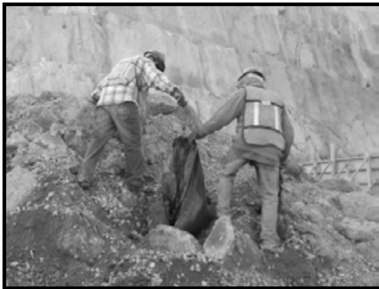
Ilustración 15. Brigada ambiental realizando limpieza de la obra en general.
