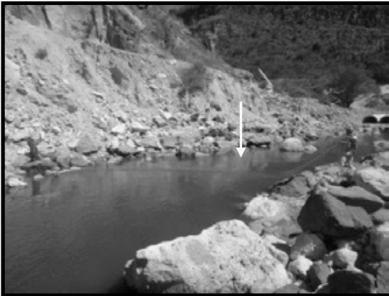
Ilustración 137. Colocación de tumbo para evitar el paso de fauna durante las actividades de construcción.
