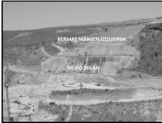
Ilustración 2. Vista general de la ladera margen izquierda y muro Milán.
