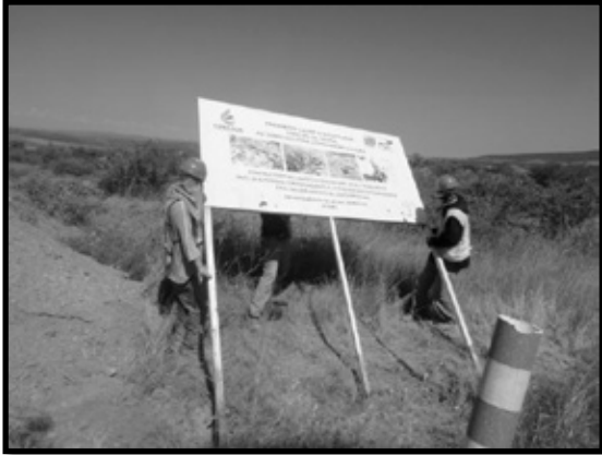
Ilustración 99. Retiro de carteles dañados.
