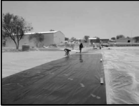
Ilustración 133. Colocación de geomembrana en taller de mantenimiento de maquinaria mayor.
