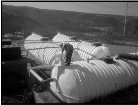
Ilustración 23. Vista de Planta de Tratamiento de Aguas Residuales para el proyecto de cortina, la cual recibe mantenimiento de forma rutinaria.
