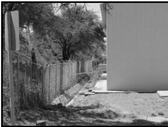
Ilustración 97. Malla ciclónica que delimita la zona de infraestructura temporal.
