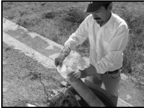
Ilustración 20. Colocación de pastillas de cloro en PTAR.
