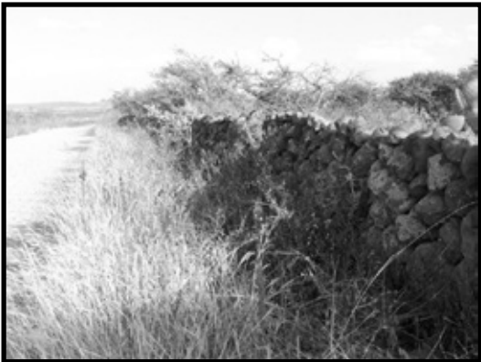
Ilustración 43. Delimitación de predios con cercos de piedra en camino de acceso a obra.
