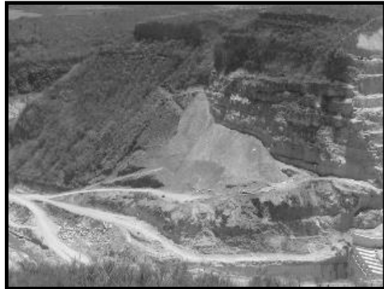
Ilustración 85. Vista panorámica del área de toppling.
