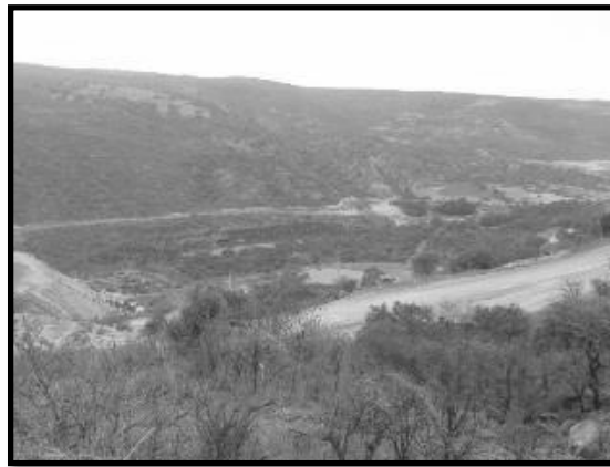
Ilustración 122. . Vista parcial de zona proyecto de construcción de Cortina. Obsérvese la ocupación de áreas exclusivamente necesarias para la ejecución de los trabajos.
