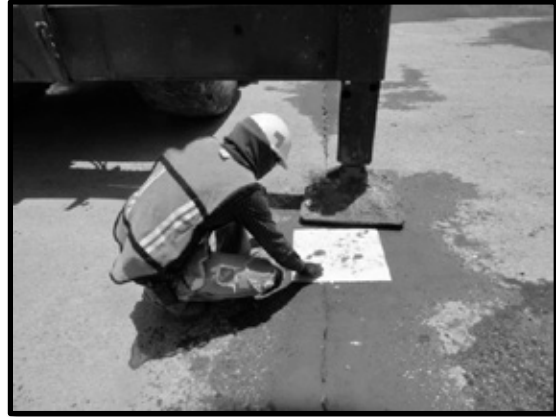
Ilustración 123. Uso de material absorbente en caso de derrames accidentales.
