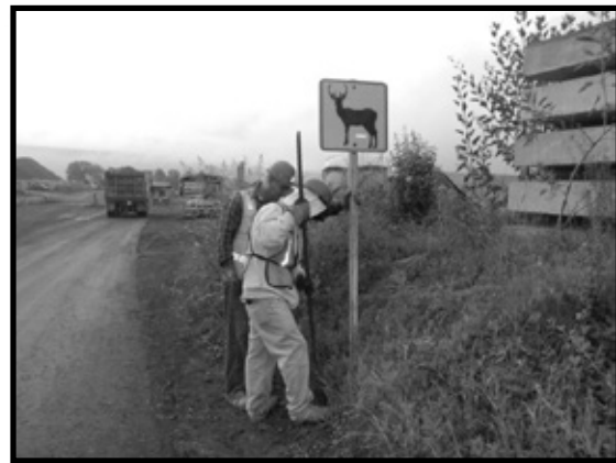
Ilustración 56. Reubicación de señalamiento de presencia de fauna
