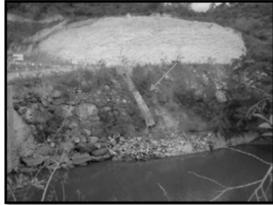
Ilustración 100. Obra de drenaje para conducción de agua pluvial
