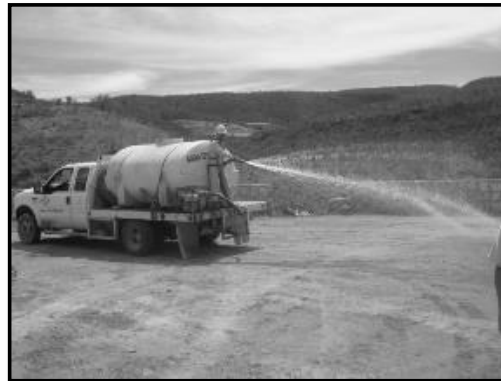
Ilustración 32. Riego de la plataforma de la Subestación Electrica Switcheo uno.
