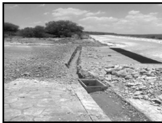
Ilustración 34. Demoliciones y desmantelamientos para
