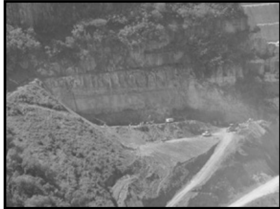
Ilustración 67. Tratamiento con concreto lanzado en paredón de zona de toppling
