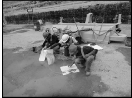
Ilustración 128. Uso de material absorbente para limpieza del área.
