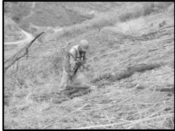
Ilustración 121. Desmonte manual con ayuda de hacha en área de toppling
