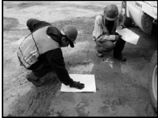
Ilustración 130. Uso de tela absorbente de hidrocarburos para atención a derrames accidentales de residuos peligrosos.
