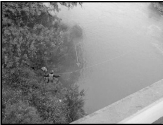
Ilustración 142. Intento de colocación de tumbo para evitar el paso de fauna hacia aguas abajo.
