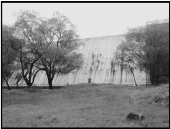
Ilustración 27. Vista Parcial de la Presa El Jihuite
