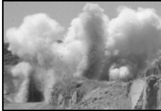
Ilustración 27. Voladura en Banco de préstamo de materiales La Palma.
