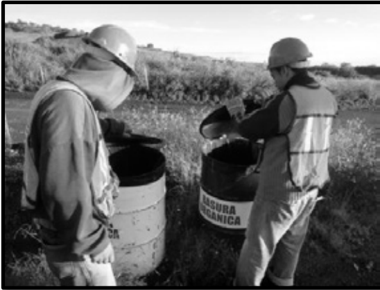
Ilustración 124. Revisión diaria de tambos distribuidos en obra.
