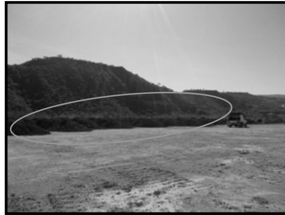
Ilustración 97. Acopio temporal de suelo orgánico recuperado de la zona de impacto.
