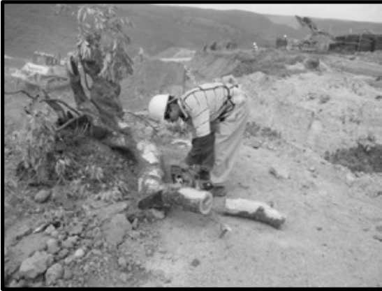
Ilustración 120. Uso de motosierra para retiro de masa vegetal en excavación margen izquierda
