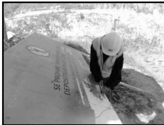
Ilustración 73 Mantenimiento a carteles informativos/prohibitivos instalados en el proyecto.
