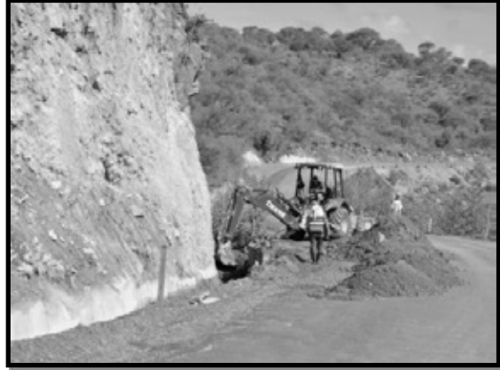
Ilustración 110. Desazolve de cunetas en vialidades internas del proyecto para el correcto escurrimiento de aguas pluviales.
