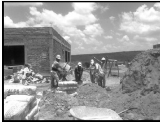
Ilustración 38. Correcta utilización del equipo de seguridad del personal de construcción.
