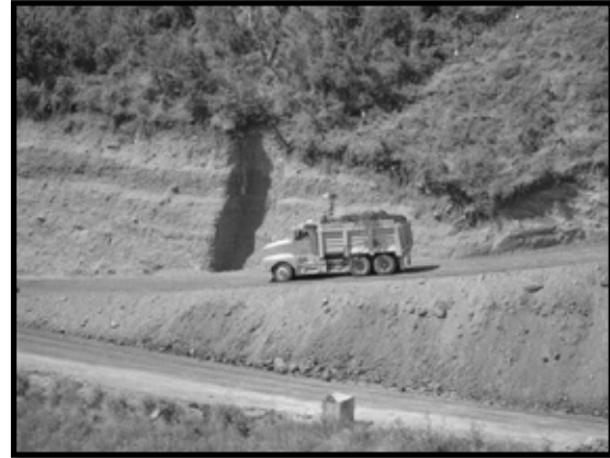
Ilustración 106. Recuperación de suelo orgánico durante actividades de excavación.
