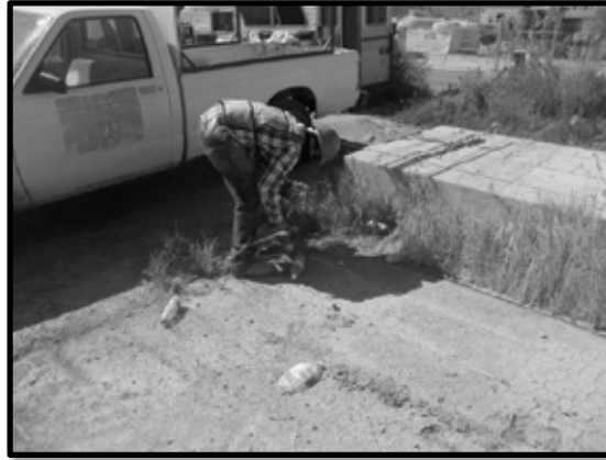
Ilustración 126. Personal realizando la limpieza de los frentes de trabajo.
