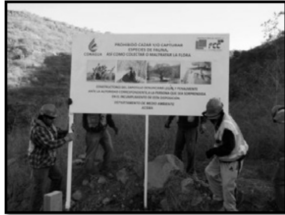
Ilustración 104. Colocación de cartel de protección a la fauna posterior a su mantenimiento.
