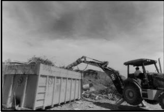
Ilustración 153. Llenado de contenedores con acero de desecho para su posterior disposición.
