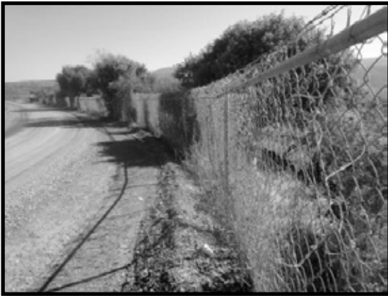
Ilustración 89. Malla ciclónica instalada para delimitación de zona de campamentos.
