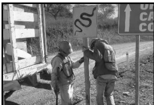
Ilustración 111. Colocación de señalamiento sobre presencia de serpientes.
