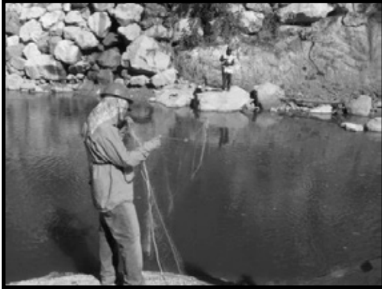
Ilustración 1. Colocación de tumbo para evitar el paso de fauna hacia aguas abajo durante las actividades de construcción.
