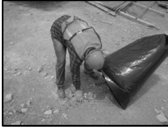
Ilustración 128. Limpieza de los frentes de trabajo.
