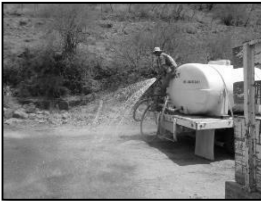
Ilustración 31. Riego del camino de accesos a la Subestación Electrica Switcheo uno.
