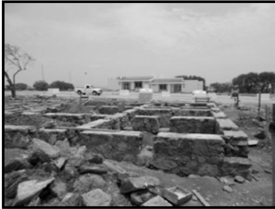
Ilustración 29. Se realizan trabajos preliminares y de cimentación sobre la manzana 4, lotes 1, 2, 4, 5, 6, 7, 8,9 y 10.
