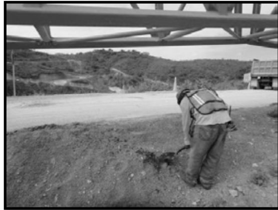
Ilustración 81. Recuperación de suelo contaminado por hidrocarburos.
