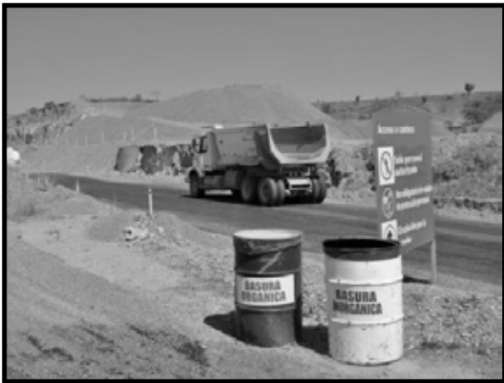
Ilustración 6. Tambos identificados y distribuidos en la obra.
