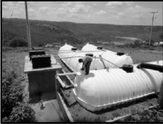
Ilustración 16. Planta de tratamiento de aguas residuales.
