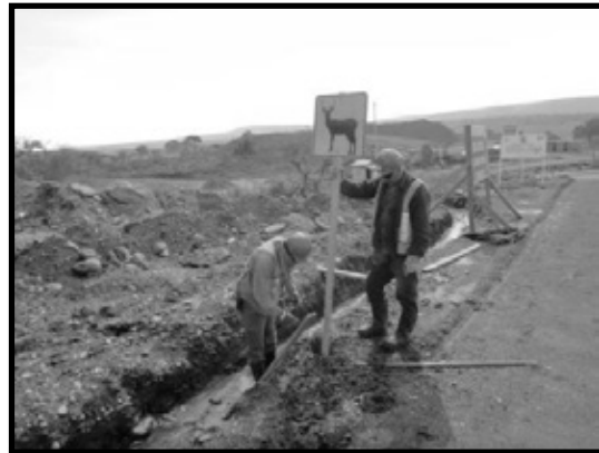
Ilustración 98. Señalamiento alusivo a la presencia de venado cola blanca en zona de obra.
