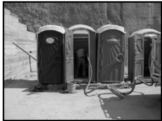
Ilustración 93. Limpieza de sanitarios portátiles distribuidos en zona de obra.
