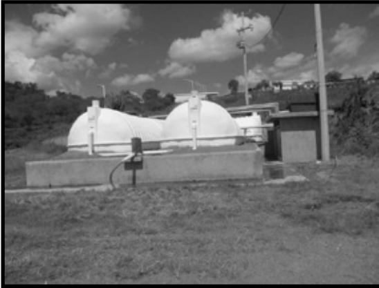
Ilustración 12. Vista de la Planta de Tratamiento de Aguas Residuales (PTAR) instalada en el proyecto
