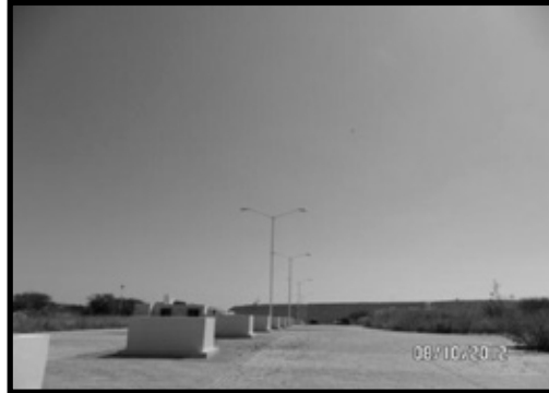
Ilustración 36. Alumbrado público sobre avenida principal.
