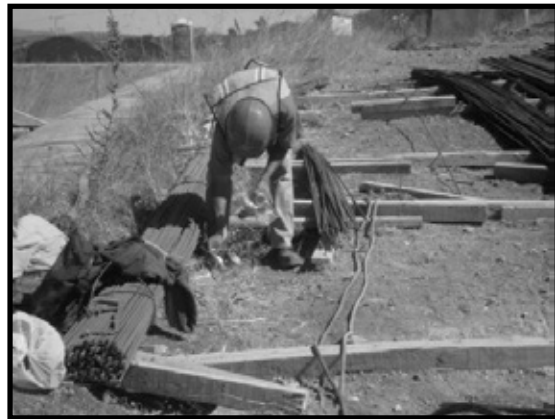
Ilustración 16. Personal de construcción realizando limpieza de su frente de trabajo
