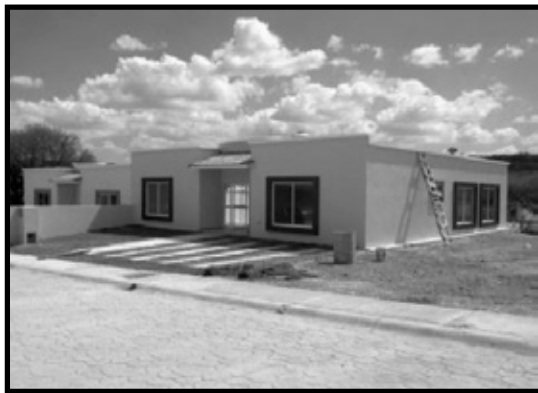
Ilustración 31. Se observa una de las construcciones del nuevo poblado de Temacapulín, sin embargo por el momento las actividades se encuentran detenidas
