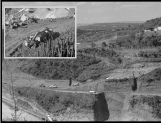
Ilustración 105. Excavación de ladera izquierda.
