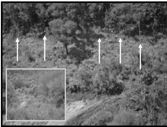
Ilustración 103. Delimitación mediante banderas en zonas de excavación de ladera izquierda.
