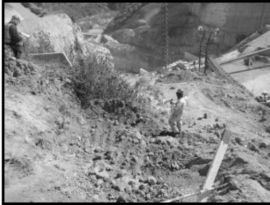
Ilustración 135. Ahuyentamiento de fauna con ayuda de megáfonos en apertura de camino de acceso a la cortina.
