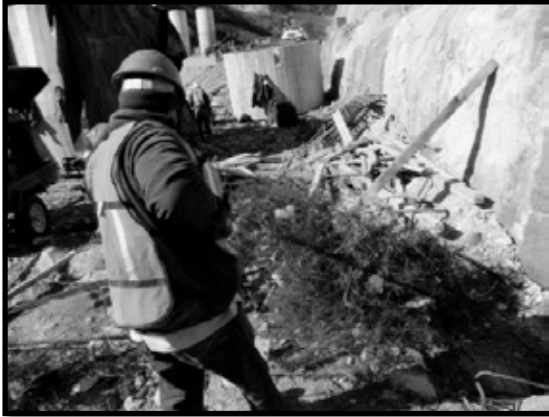
Ilustración 136. Recolección de residuos de manejo especial de los frentes de obra.
