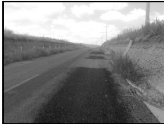
Ilustración 40. Camino de acceso secundario reparado.
