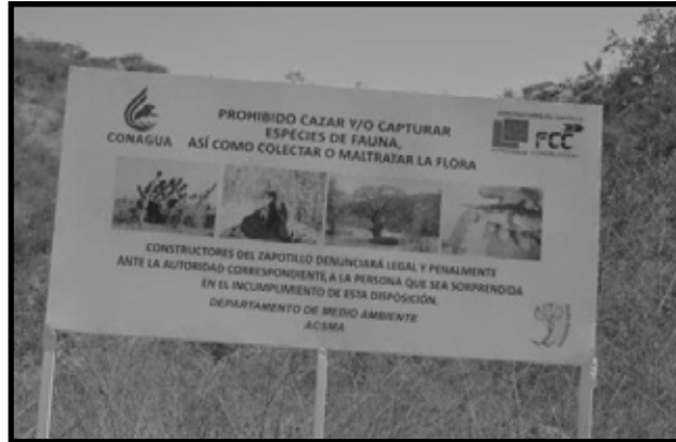
Ilustración 94. Cartel prohibitivo instalado en obra.
