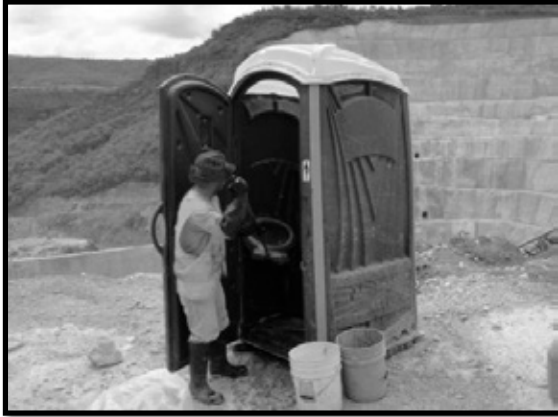
Ilustración 101. Limpieza de sanitarios portátiles distribuidos en zona de obra.
