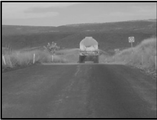
Ilustración 25. Riego de camino VCD-1.
