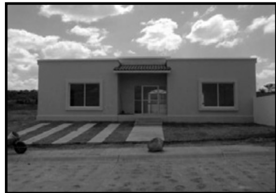
Ilustración 32. Fachada terminada de una da las viviendas del nuevo poblado de Temacapulín, actualmente las actividades se encuentran detenidas
