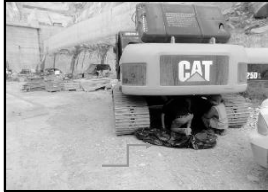
Ilustración 141. Reparación "in situ" de los equipos, obsérvese el uso de bases plásticas.
