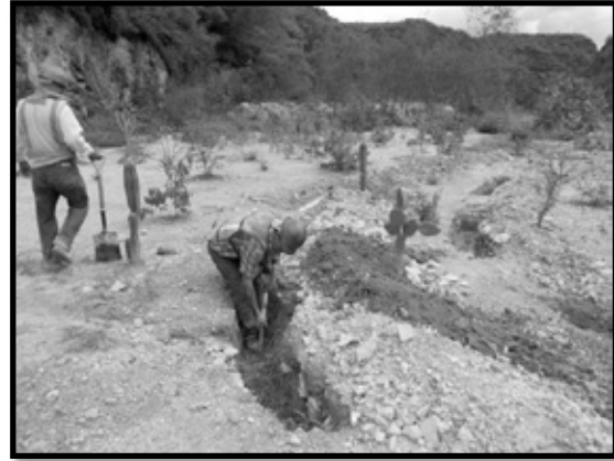
Ilustración 62. Mantenimiento realizado durante la temporada de lluvias
