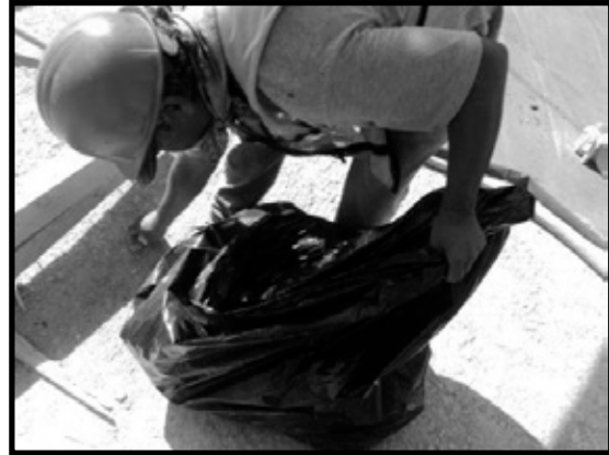
Ilustración 13. Limpieza general de los frentes de trabajo.
