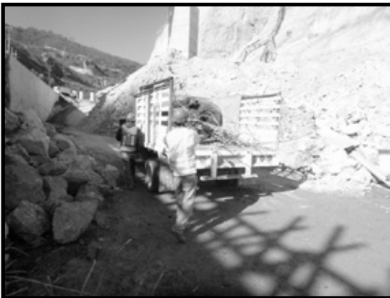
Ilustración 14. Retiro de RME de los frentes de obra.
