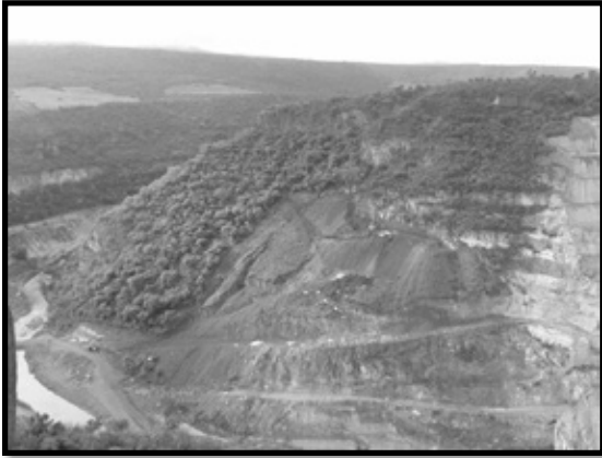
Ilustración 66. Proceso de excavación para retiro de material geológico inestable
