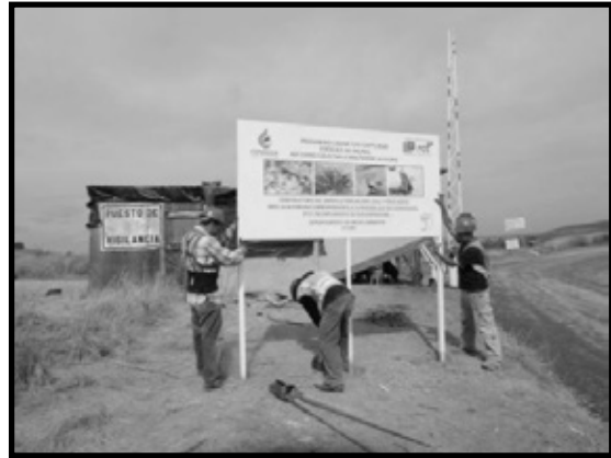
Ilustración 74. Cartel informativo de fauna instalado en puerta de acceso principal.
