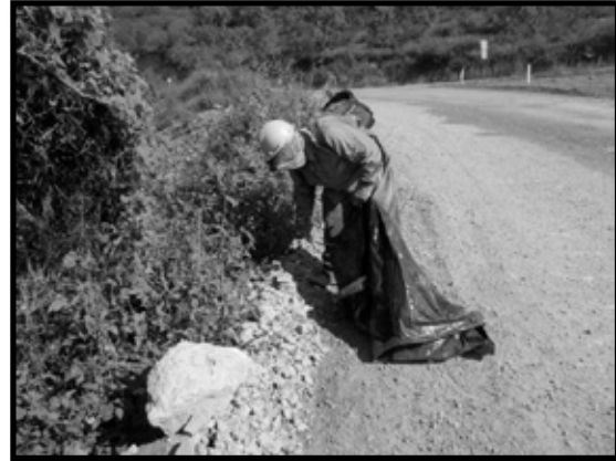
Ilustración 9. Personal de construcción realizando limpieza de la obra en general
