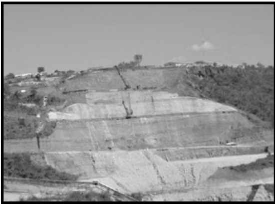
Ilustración 66. Proceso de excavación para retiro de material geológico inestable
