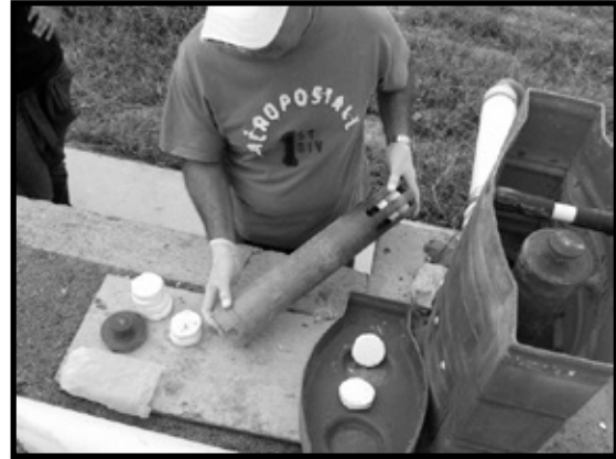
Ilustración 13. Cambio de pastillas tricloro como tratamiento terciario
