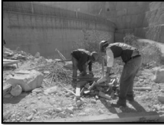
Ilustración 17. Retiro de residuos de manejo especial de los frentes de obra.
