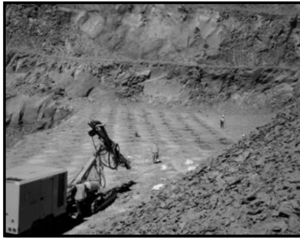
Ilustración 33. Acciones de preparación de voladura en el Banco Potrero, Convenio y El Victoriano “La Palma”
